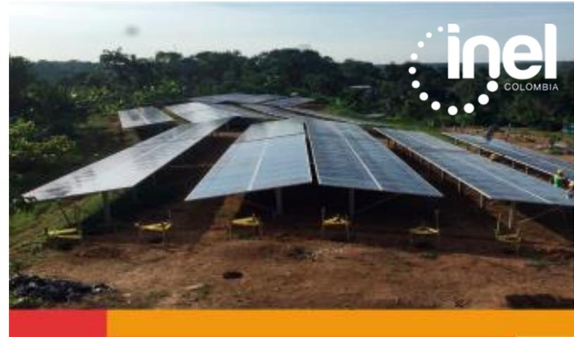
Microred 165 kWp. 660 paneles instalados. 360 baterías de 3.500Ah
