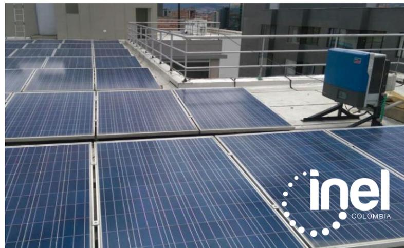
Conexión a red Autoconsumo. 20 kWp. 80 paneles instalados. Bogotá.
