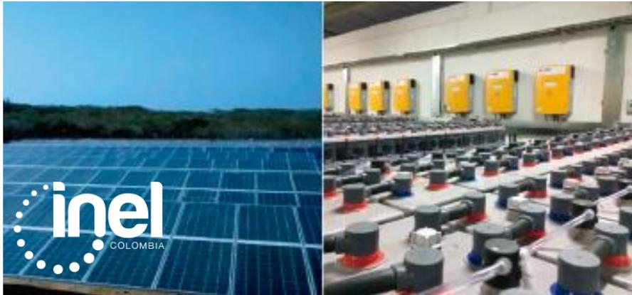
Microred 320 kWp. 1.200 paneles instalados. 3.148 kWh en 480 baterías
