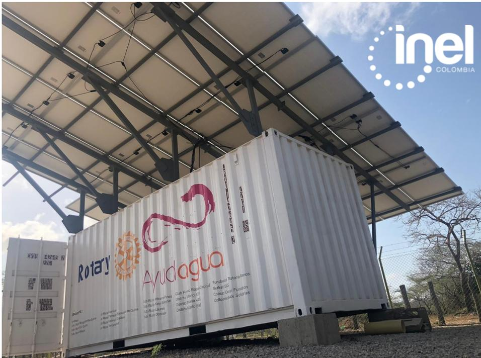
Generador Atmosférico de agua de 300 litros/día alimentado con paneles solares en la Guajira colombiana
