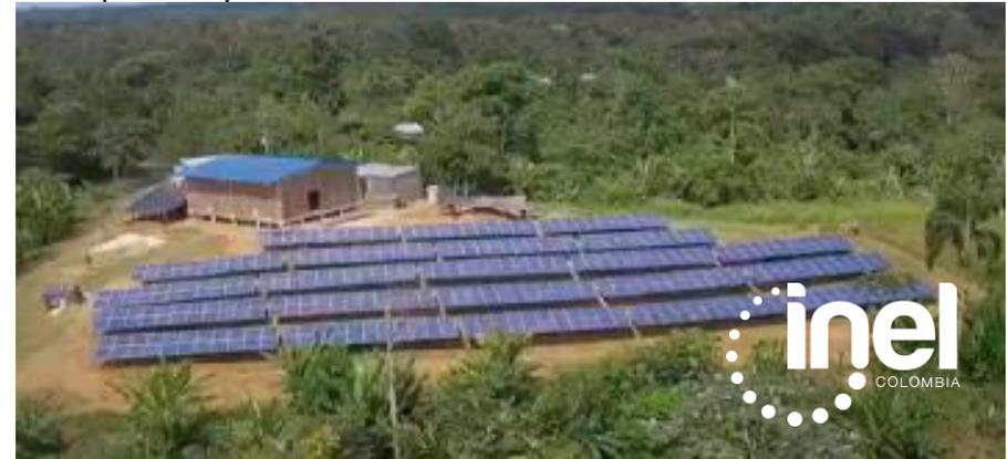
Microred 120 kWp. 480 paneles instalados. 240 baterías de 3.500Ah
